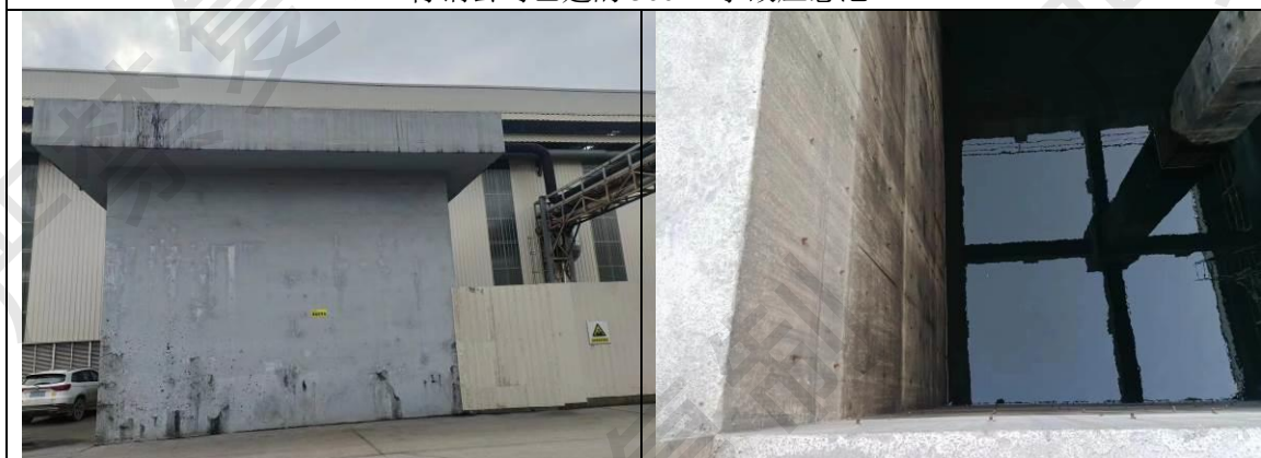
特钢公司已建的 480m 3 事故应急池
