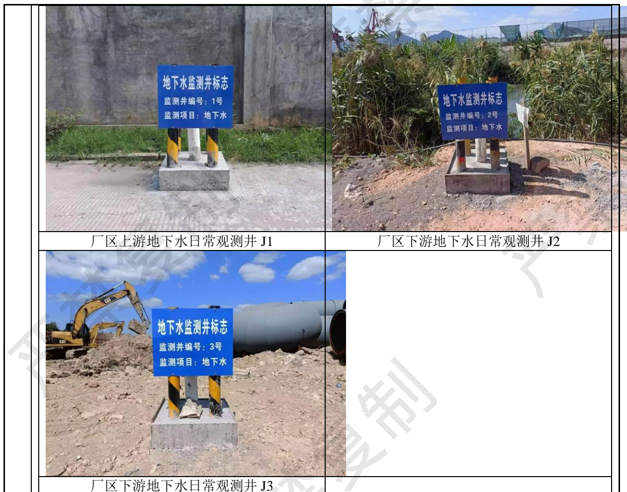
图 2.3-12 地下水监控井现场照片
