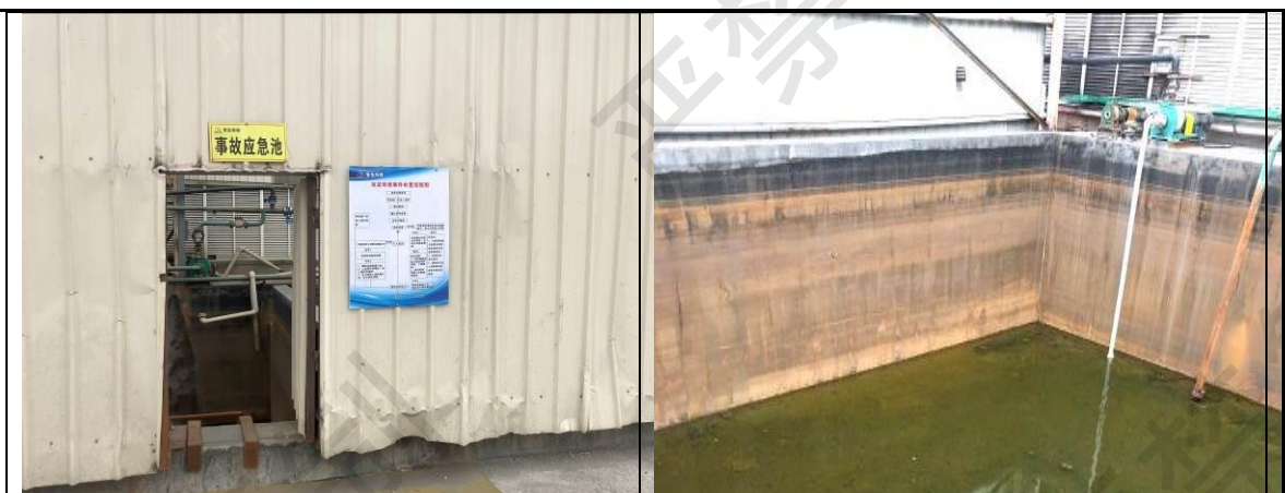
特钢公司已建的 300m 3 事故应急池
